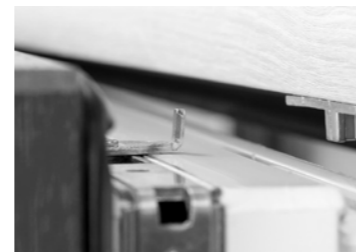
MECHANIZM STOPNIOWANEGO UCHYŁU
